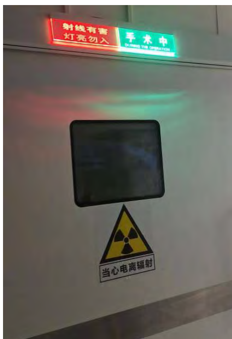
患者出入口设置的放射性标志、中文警示说明和“射线有害 灯亮勿入”工作状态灯箱
