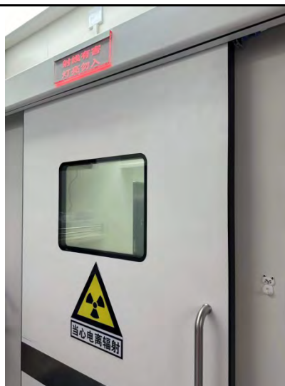
控制室门外设置的放射性标志、中文警示说明和“射线有害 灯亮勿入”工作状态灯箱
